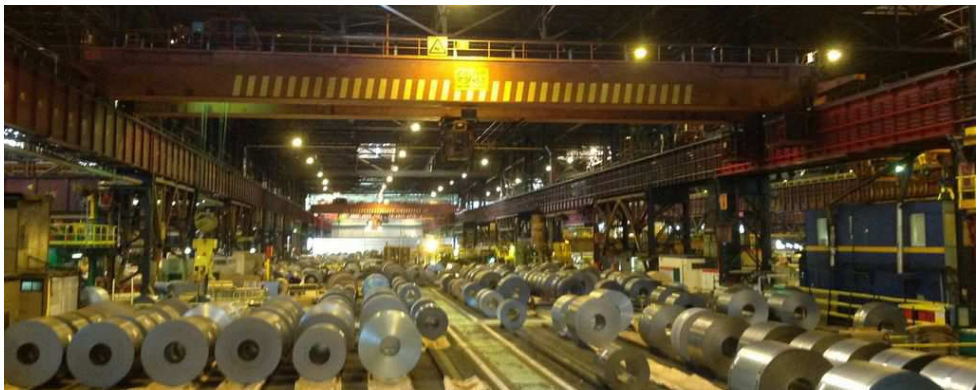
ArcelorMittal Gent telt meer dan 30 kilometer kraanbaanliggers en meer dan 240 rolbruggen variërend van 40 tot 460 ton.
